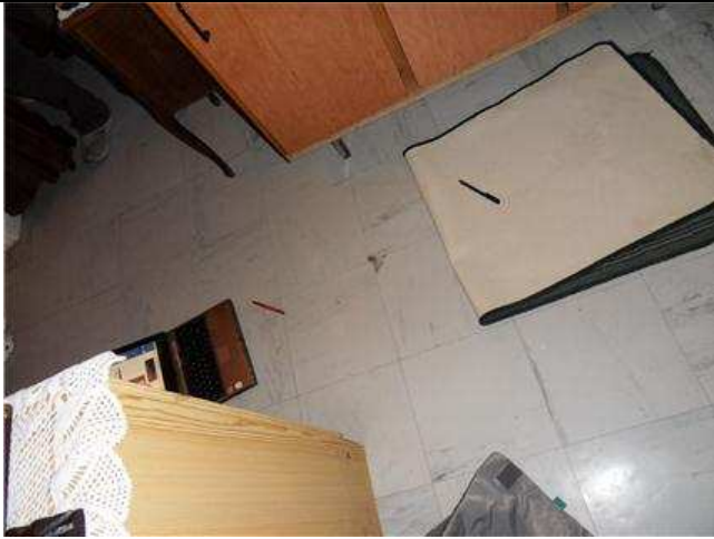
001 - Appartements - Entrée LOT 0002 PH1 : Dalle, colle, ragréage PRE:001
